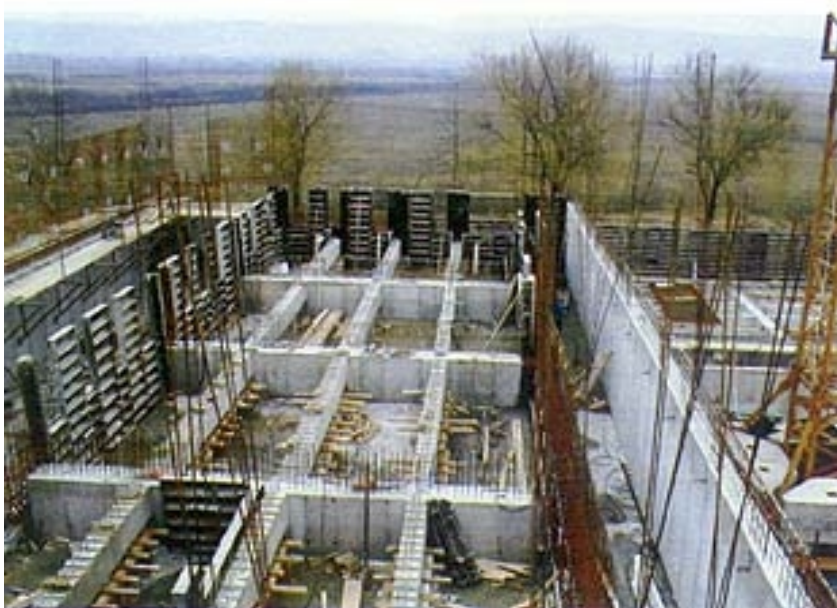
Temeljenje zgrade uređaja u listopadu 1999. godine
